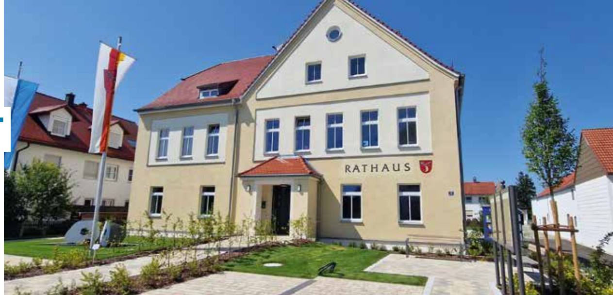
Das schöne Rathaus wurde 2023 barrierefrei ausgebaut. Foto: Gemeinde Jesenwang
